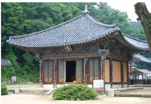
사모지붕 | 충남 보은 법주사 원통보전 | 2004 | 김왕직
