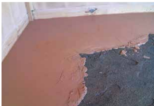
온돌바닥 미장 | 2010 | 정연상
