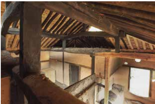
까치구멍과 까치구멍집 내부 | 경북 봉화 | 서현강
